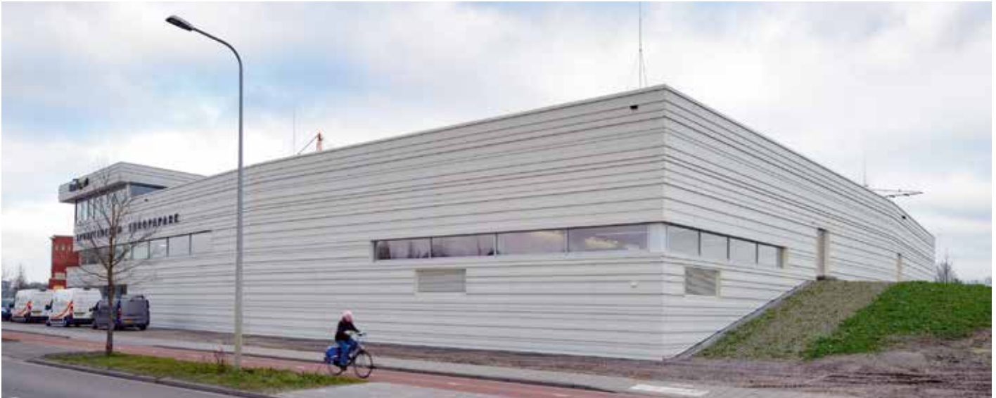
Het onregelmatige patroon van de gezette, stalen gevelbeplating, verfijnt de schaal van het gebouw.
