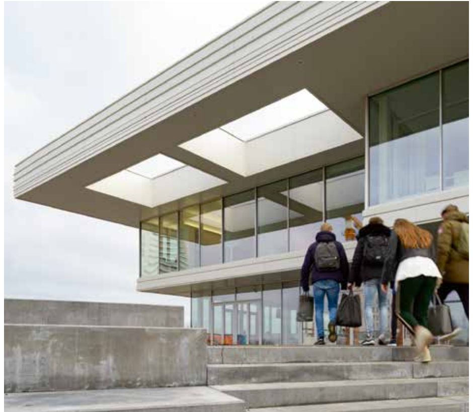
Karakteristieke luifel markeert de entree.
