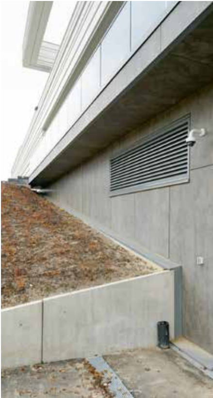
Aardbevingsdilatatie tussen gebouw en talud.
