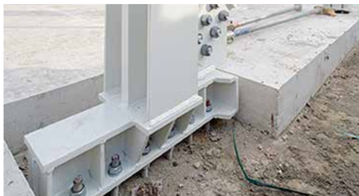
Aansluiting beton met grote horizontaal- en trekkrachten.
